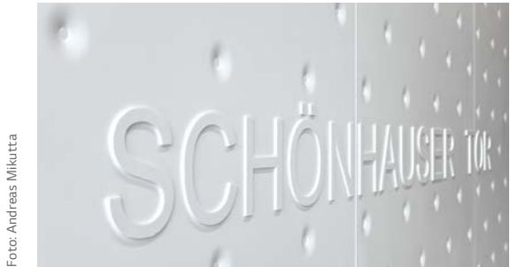
Außen effektiv bespielt, innen mit markantem Punkt-Design und mit CNC-Technik eingegrästster Schrift.
